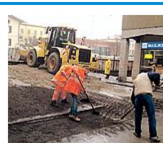
OPERE Lavori in corso a Pontassieve e dintorni
